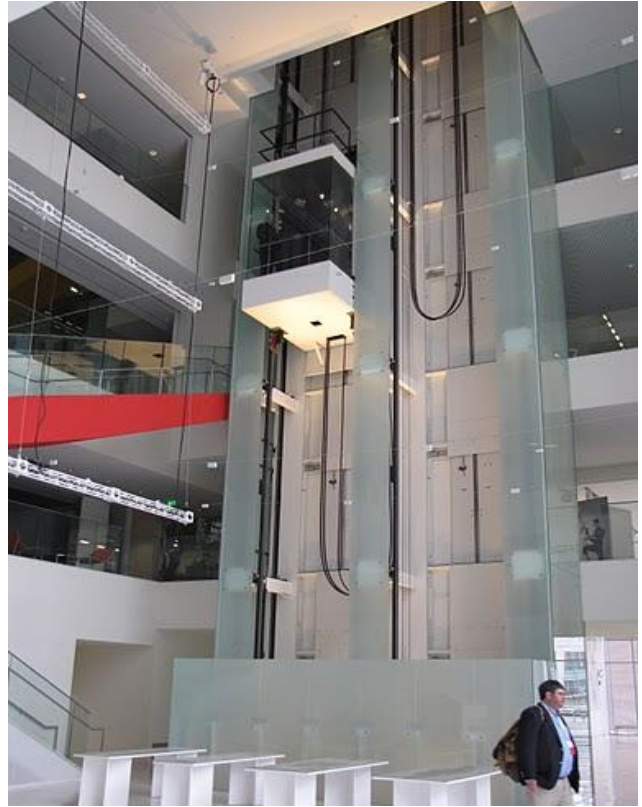
The exposed elevators in the Media-Lab atrium at MIT
